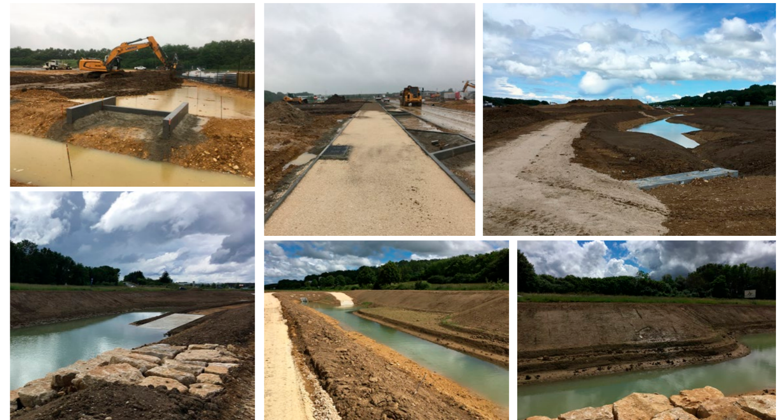
Le chantier avance !!
