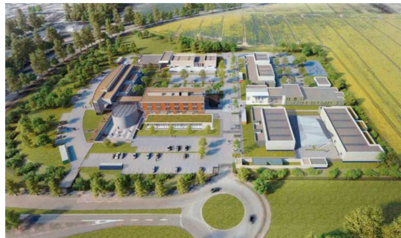
Vue d'ensemble - © 2+I
