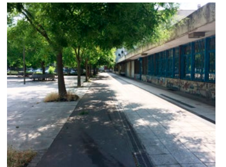
Existant - vue du caniveau sur l'allée de livraison
