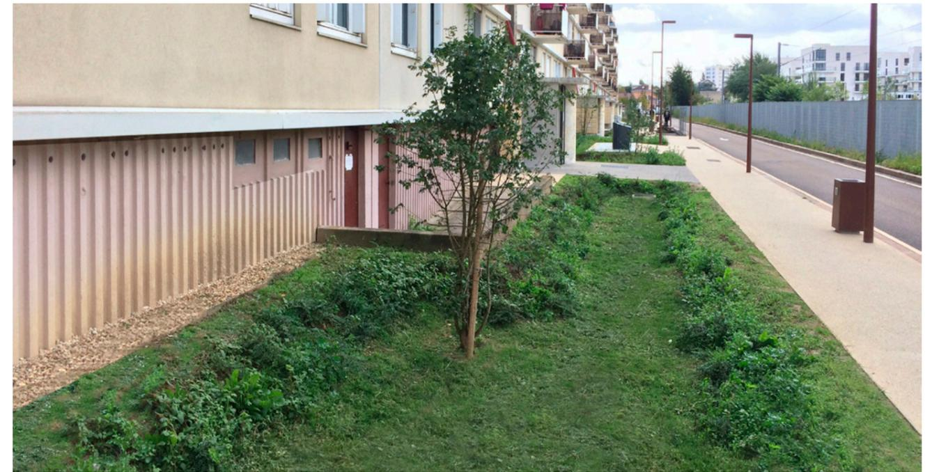
Noue de collecte et d'infiltration des eaux de toitures
