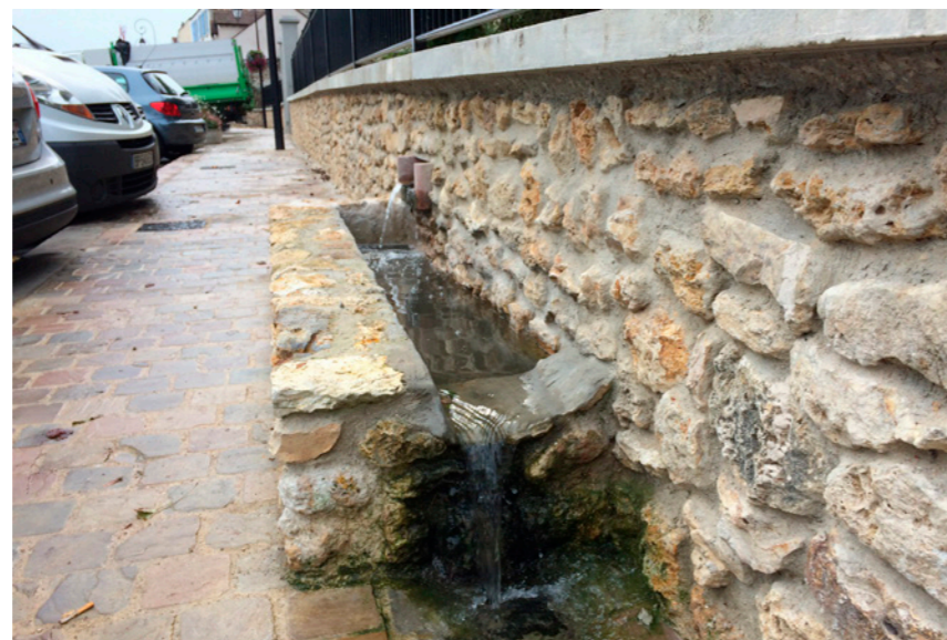
Mur de soutènement et mise en scène des eaux de sources et de pluie
