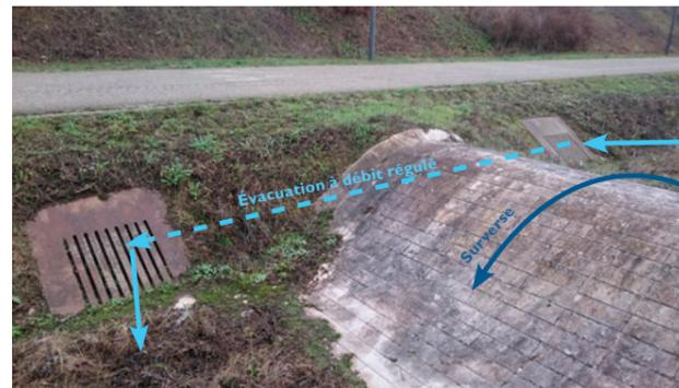
Principe d'évacuation à débit régulé et de surverse des zones inondables
