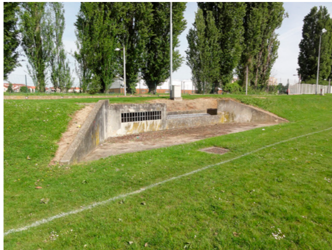
Ouvrage existant de surverse vers la Morée enterrée
